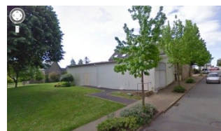
Salle de l'atelier Rue du Lavoir
